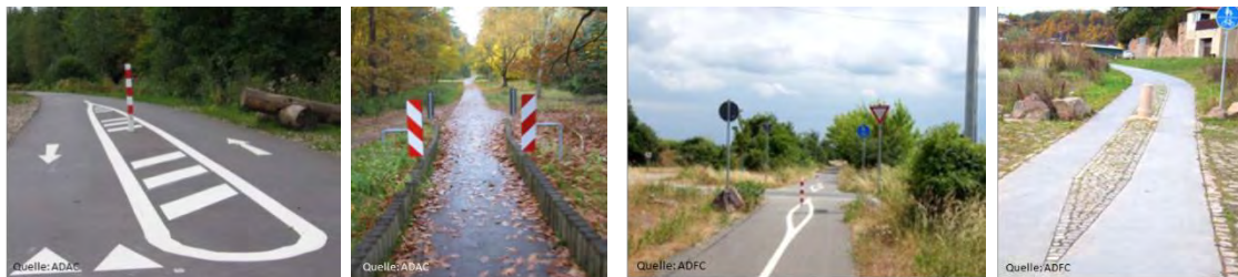
Abbildung 6-23: Poller sicher gestaltet
