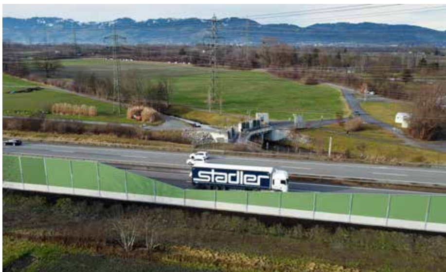
Lärmschutzwand mit Schönheitsfehler
