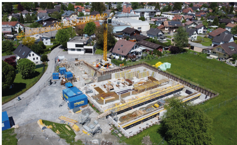
Baustelle Kindergarten Kreuzfeld
